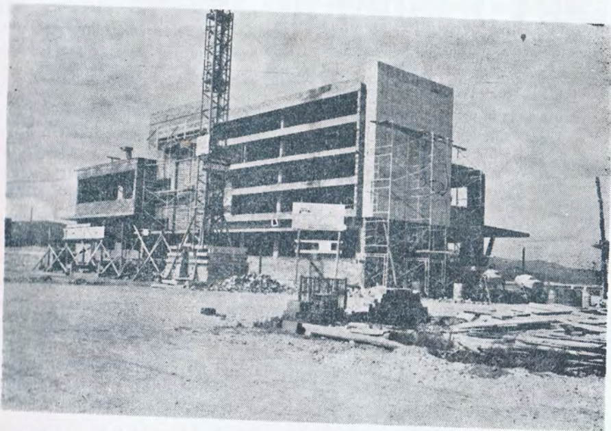
Avanzado estado de las obras del nuevo edificio e instalaciones deportivas del Liceo Marítimo de Bouzas.
