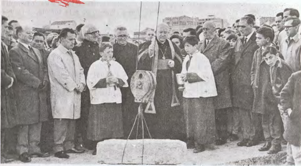
Acto de bendición y colocación de la primera piedra del «Liceo Marítimo de Bouzas»
