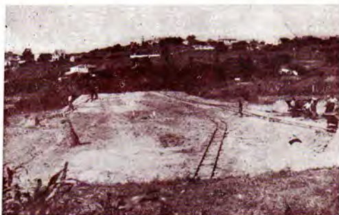
Estado actual de las obras del futuro campo de Bouzas.
