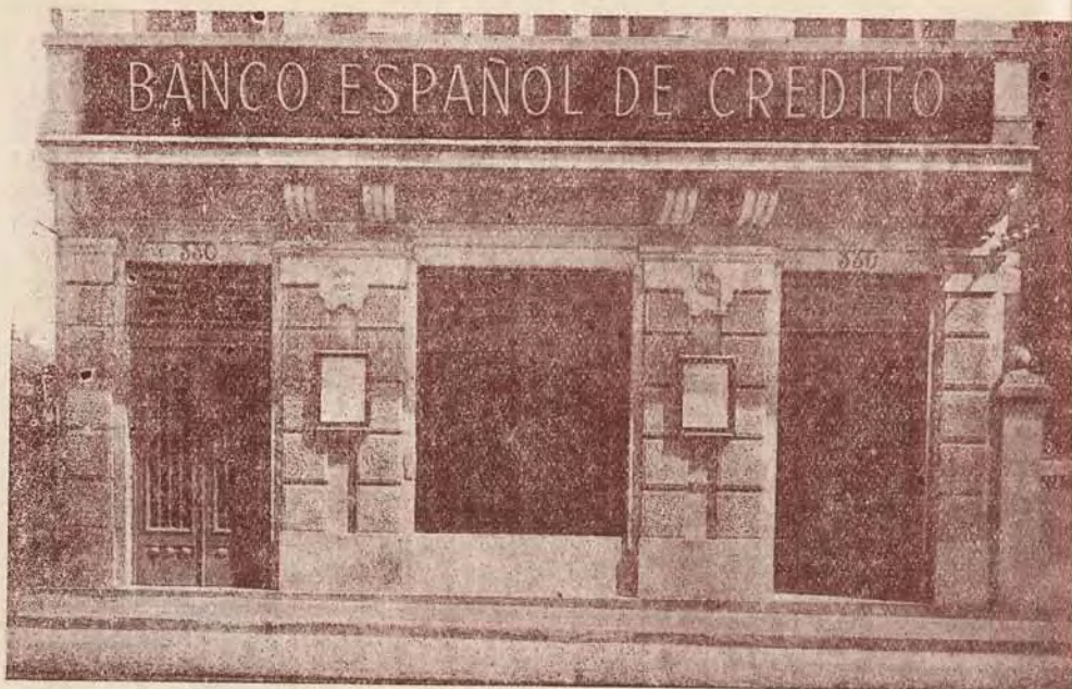
Fachada de los locales que ocupa la Sucursal del Banco Español de Crédito, sita en la calle de Tomás A. Alonso, 330 recientemente inaugurado.
