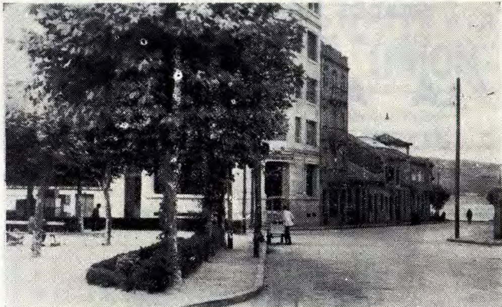
Trozo de la Avenida de E. Cabello, exponente de la modernización urbana de Bouzas.—(Foto Pacheco.)
