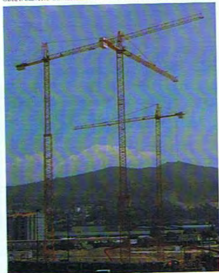
OBRA: 288 VPA NAVIA. VITRA. (DRAGADOS, S.A.)
