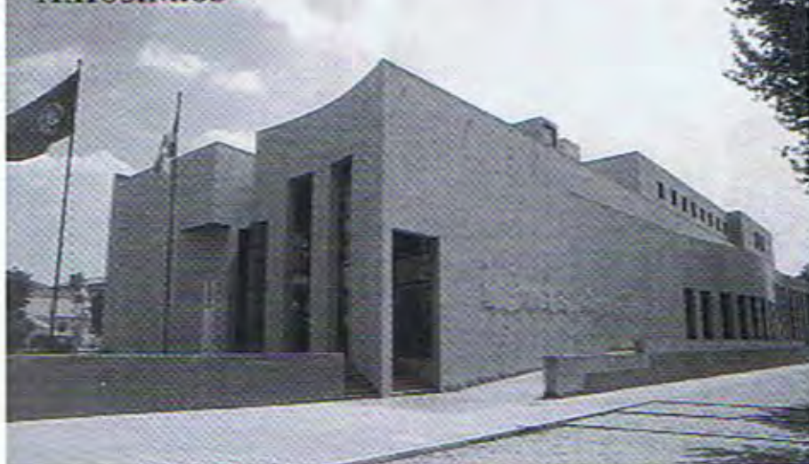
Câmara Municipal de Matosinhos, donde se ubica limitando con sus muelles, el Santuario del Srmo. Cristo,
